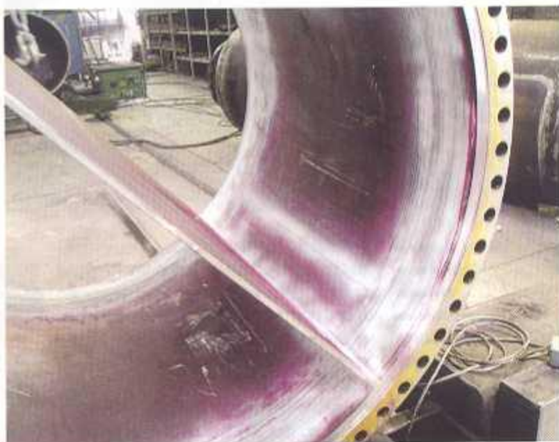
Un manufatto saldato sottoposto a controlli non distruttivi realizzato in CCM.
